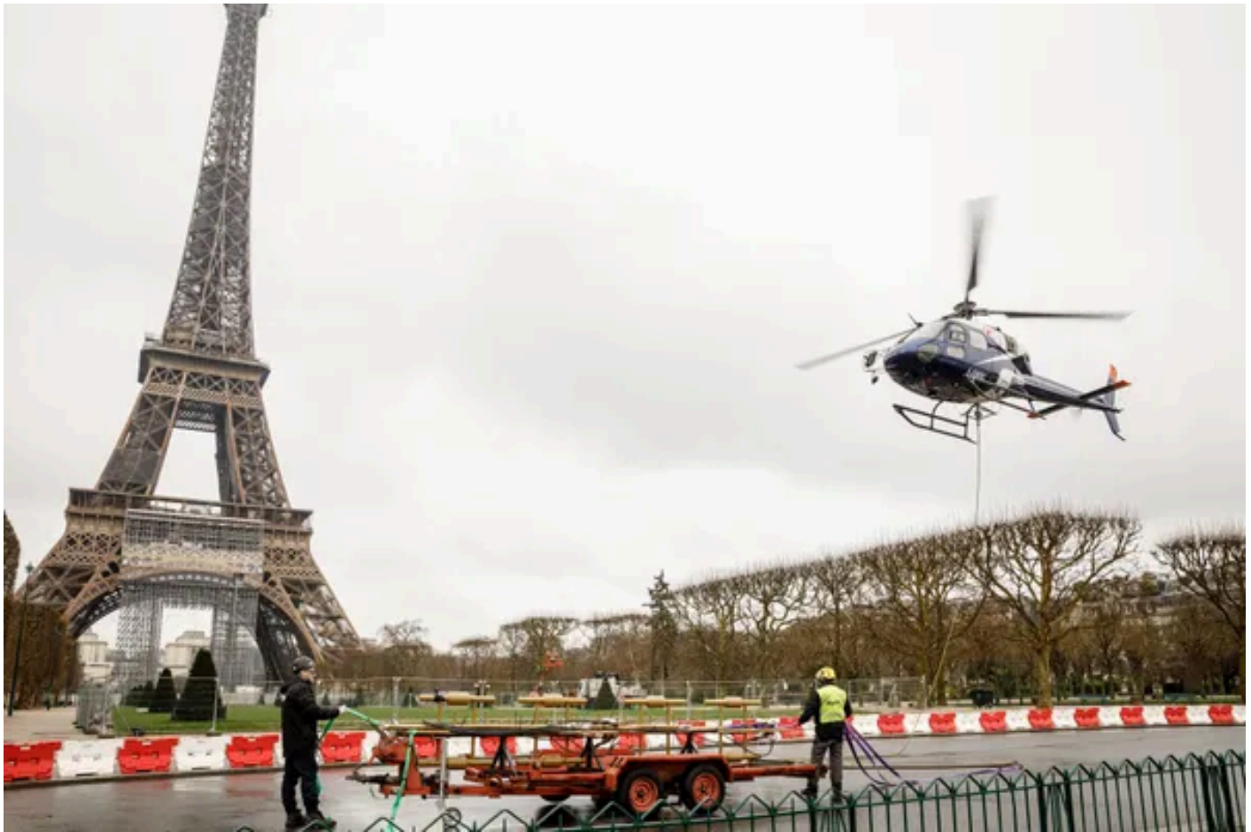
C'est à l'aide d'un crochet fabriqué à Saint-Maur qu'une nouvelle antenne a pu être installée au sommet de la Tour Eiffel. - Arésia
